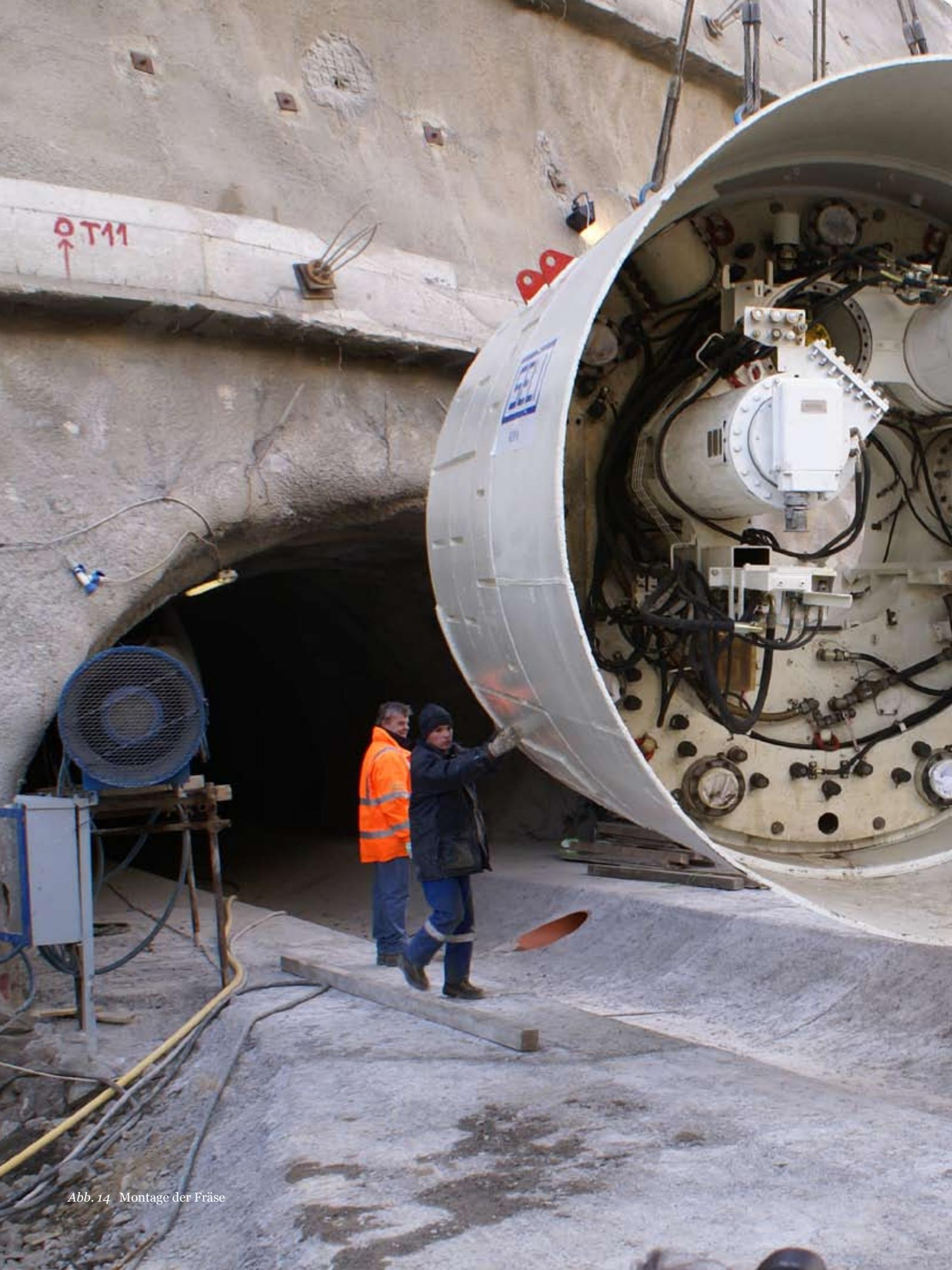
Abb. 14 Montage der Fräse
